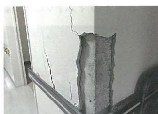
[写真1] 旧耐震基準の病棟が被災
